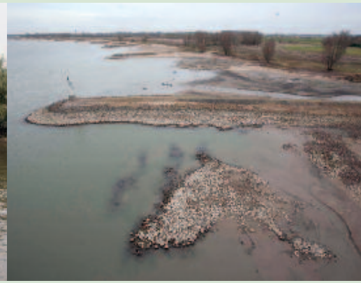
Kribvakken langs de Waal bij Nijmegen bij laag water (februari 2013). Bij laag water is zichtbaar dat zelfs eenvormige kribvakken interessante bodemstructuren bevatten die bij de inrichting van een nevengeul of strang slim ingepast zouden kunnen worden (foto M. Dorenbosch).
